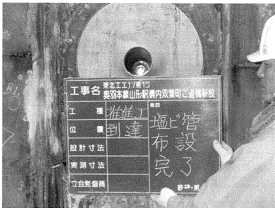
写真-9 塩ビ管布設、充填完了
